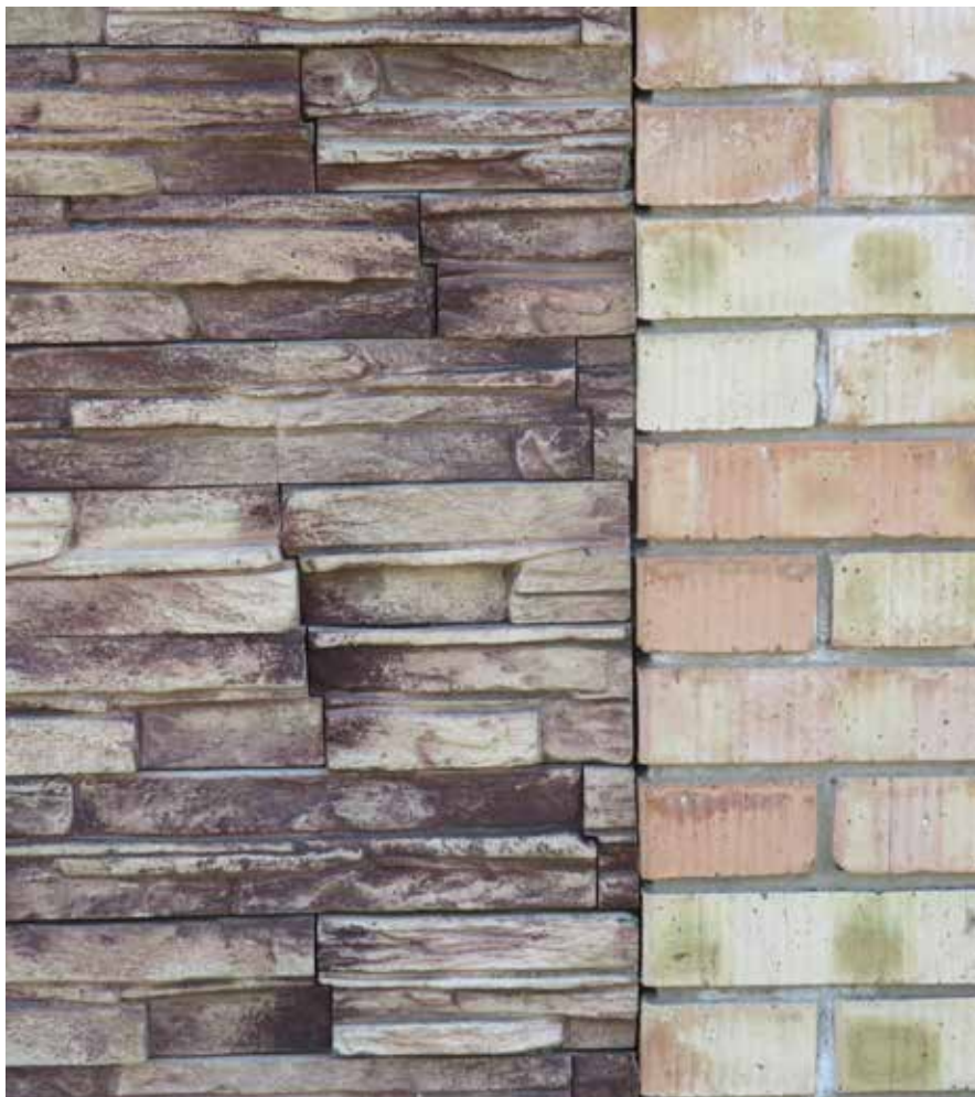
Gondosan kivitelezett kőburkolat és nyerstégla kerítésburkolatok találkozása
