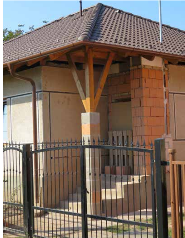
Kockaházat is lehet szépen felújítani, az új tető jó alkalmat kínált a bejárat újrafogalmazására (építés közbeni állapot).
