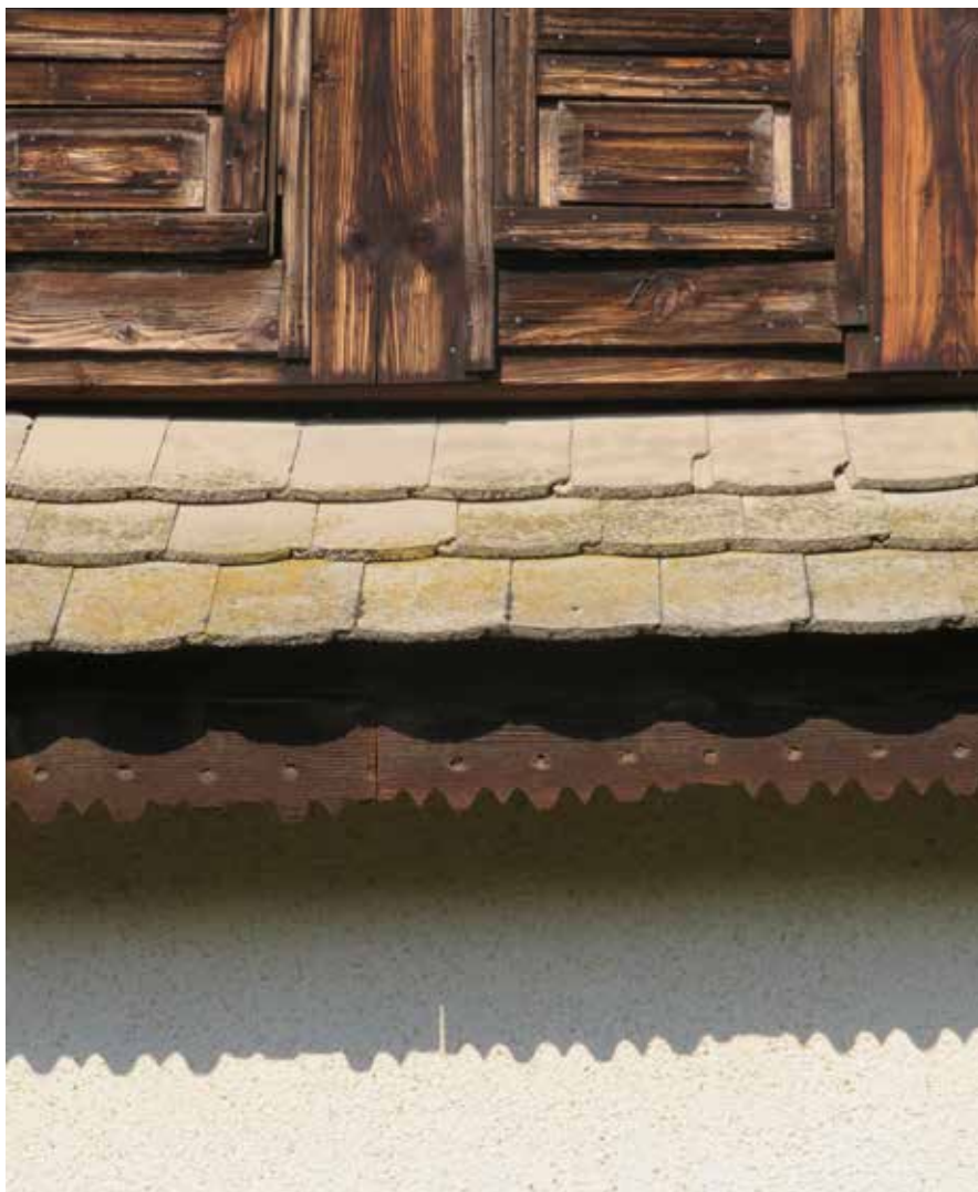
Érett színű deszkaborítás, a szegélyléc csipkézete mozgó árnyékcspkeként ismétlődik a falon.
